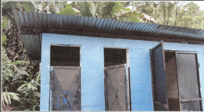
Foto1: Mantenimiento de puertas del baño del baño
