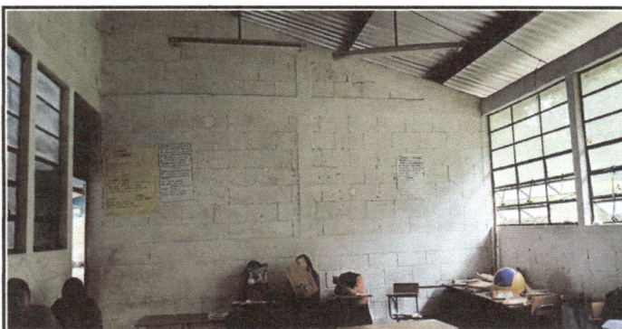
Foto 5: Aplicación de pinturas en las aulas
