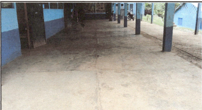
Foto 3: Sustitucion de tortado por piso ceramico (corredor)
